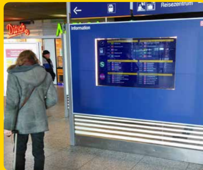
Pilotprojekt Ostbahnhof Berlin. Verbaut wurden für den Außeneinsatz geeignete LED-Monitore mit webbasierter Software. Benötigt wird lediglich ein Stromanschluss.
